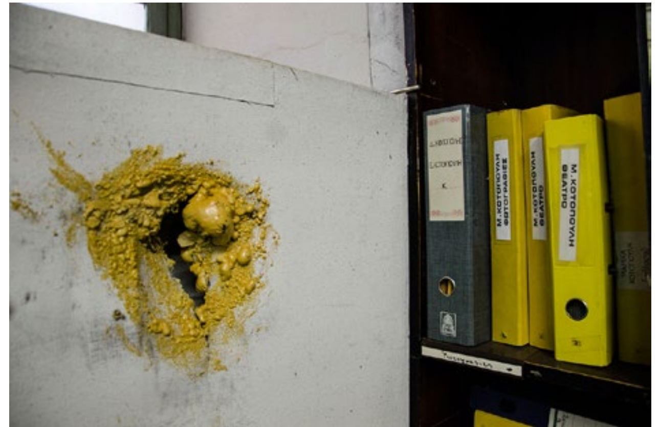
Επισκευή στο τοίχο.
